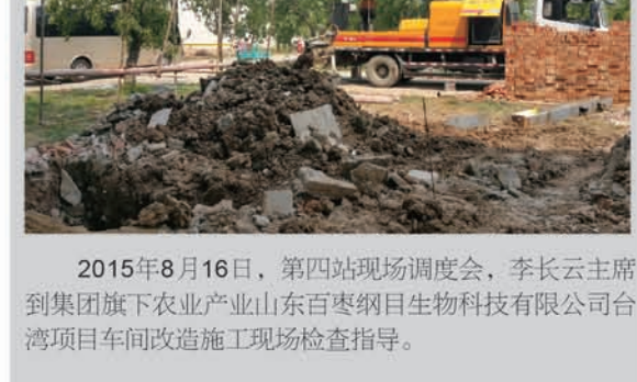
2015年8月16日，第五站现场调度会，李长云主席到集团旗下农业产业山东百枣纲目生物科技有限公司专家公寓改造施工现场，检查人工环湖，欧式阳光屋顶等项目，全员加班冲刺迎接国家级枣博会的召开。
